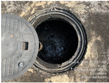
บ่อกักน้ำทิ้งก่อนผ่านระบบบำบัดน้ำเสียของอาคารที่พักผู้โดยสาร
