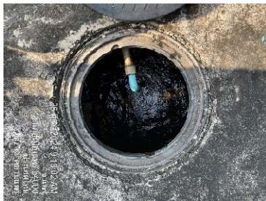
บ่อกักน้ำทิ้งหลังผ่านระบบบำบัดน้ำเสียของอาคารที่พักผู้โดยสาร
